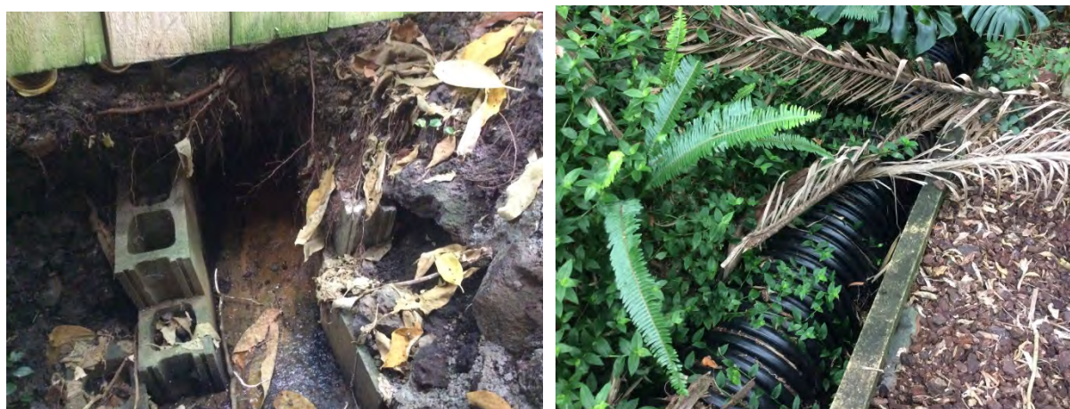
Cinder block culvert GLDSP_011.
